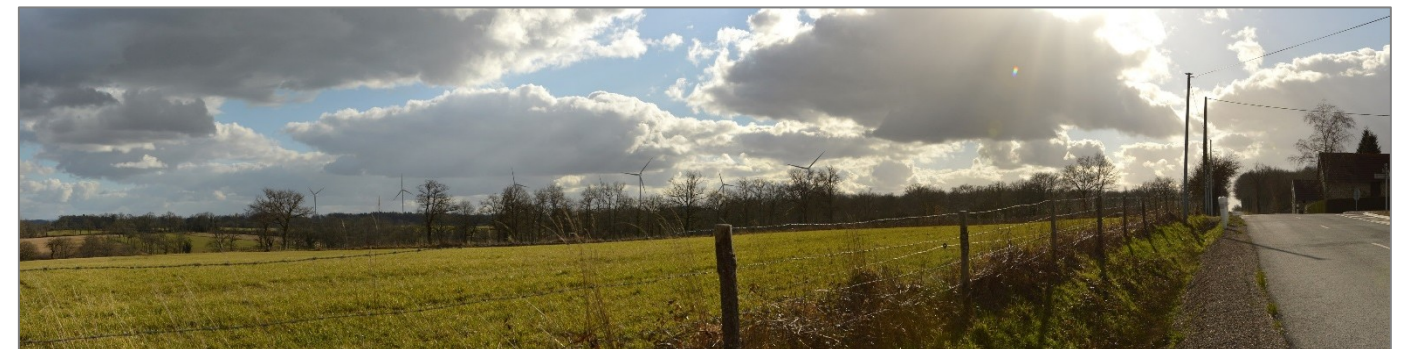
Vue depuis une route et un lieu de vie proche, la D2 au niveau du Four à Chaux, à 2 025 m du projet
